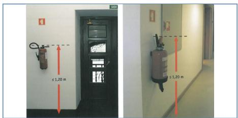
Figura n.º: Exemplos de instalação de extintor. (in "Manual de Segurança Contra Incêndio em Edifícios, de Carlos Ferreira de Castro e José Barreira Abrantes)
